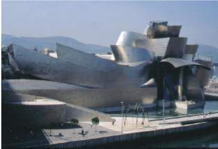
Görsel 29: Frank Ghery tarafından 1997 yılında tasarlanan bu bina Bilbao-İspanya'da bulunan Guggenheim Müzesi'dir. Teknolojinin ve çağımız malzemelerinin birleştirildiği bu yapı çelik karkas titanyum yüzeyleriyle inşa edilmiştir. Müze savaş uçakları için gerçekleştirilen bilgisayar programı kullanılarak projelendirilmiştir. Bir balinaya benzetilen müze binası mimari anlamda oldukça deneysel bir yapıdır.
