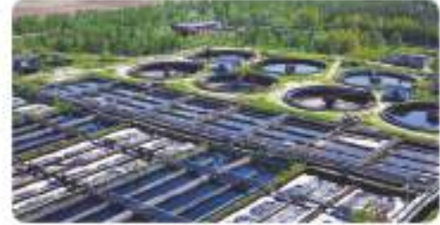
Su arıtma tesisi
