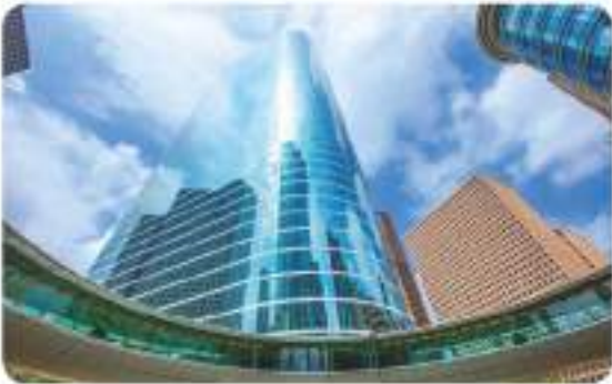
Dış yüzeyi ayna kaplı bina
