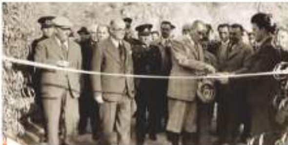
4.33 Sıngöç Köprüsü'nün açılışı, Tunceli, 1937
