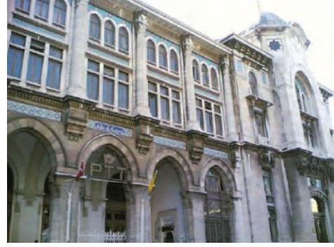
Görsel 2: Büyük Postane Binası, Mimar Vedat Tek, Sirkeci, İstanbul, 1909.
