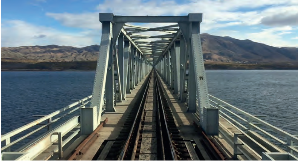
Görsel 3: Fırat Demiryolu Köprüsü, TCDD, 1986.
