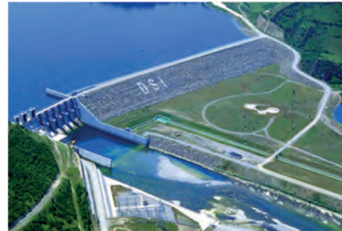
Görsel 9: Bir Hidroelektrik Baraj ve Santrali
