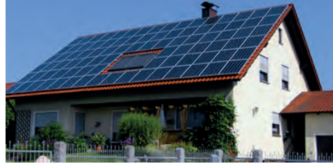
Görsel 22: Güneş Panelli Çatı
