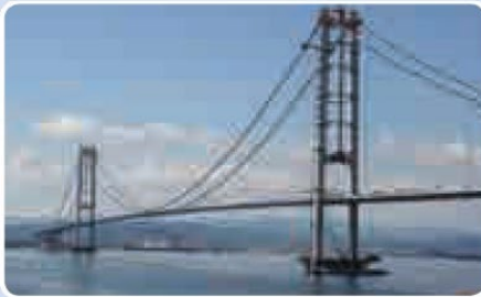
Osmangazi Köprüsü, Kocaeli-Yalova
